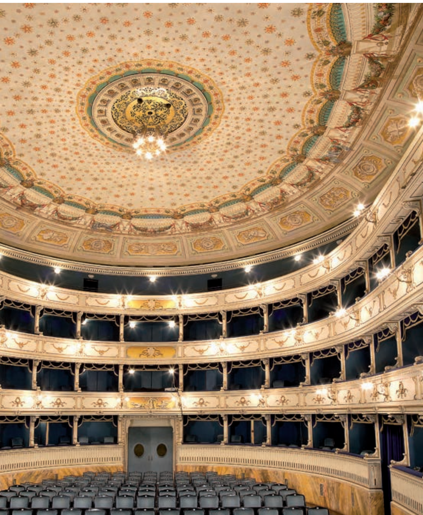
Restauro conservativo del Teatro dei Rozzi di Siena. Interventi eseguiti sulle parti decorative del soffitto, galleria e palchi.
